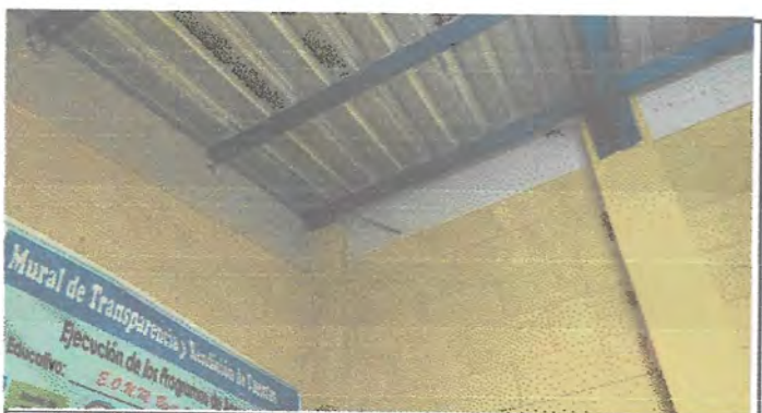
Sustitución de cielo falso reticulado
