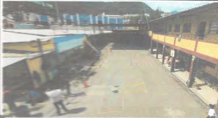
Sustitución de pedregal de concreto de 0.3x0.3x1.0m
