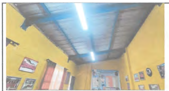
Sustitución de cielo falso reticulado
