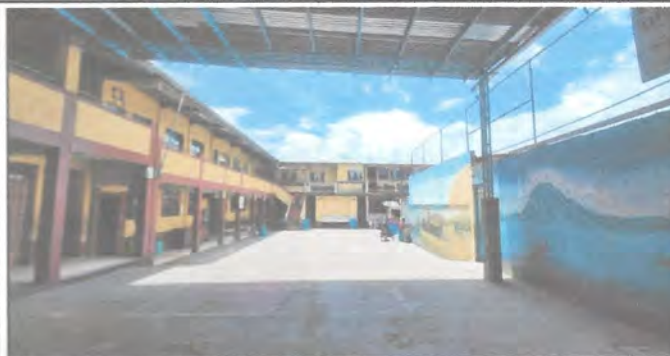
Sustitución de pedestal de concreto de 0.3x0.3x1.0m
