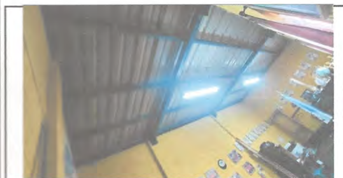
Sustitución de cielo falso reticulado
