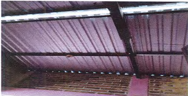
Foto 3: entechado de cocina
