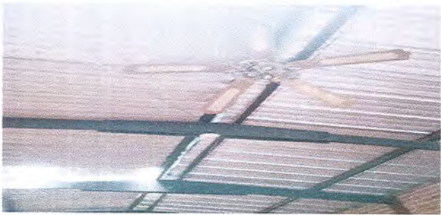
Foto1: entechado del pasillo
