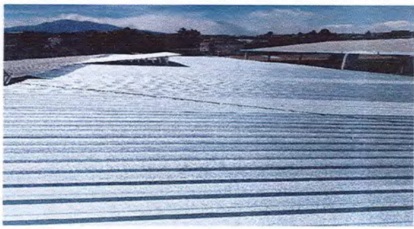
Foto 6: Acabado final de cambio de laminas
