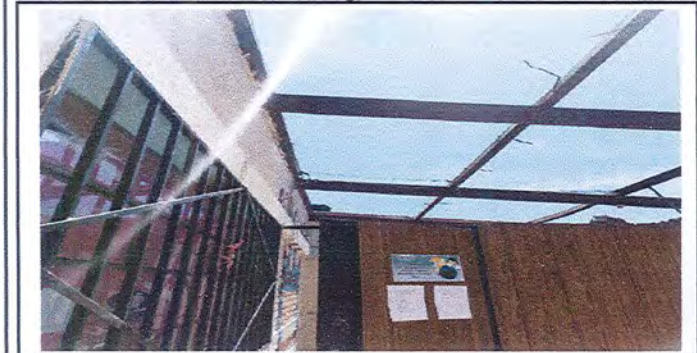
Foto 3: Desenchetado del area de remozamiento
