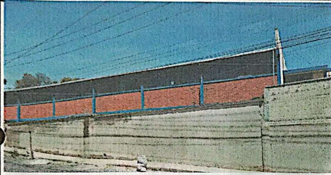
Foto 1: APLICACIÓN DE REPELLO Y REMOLINEADO FINO
