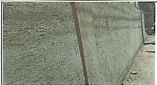
Foto 2: APLICACIÓN DE REPELLO Y REMOLINEADO FINO
