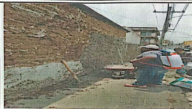
Foto 2: APLICACIÓN TRATAMIENTO ADOBE
