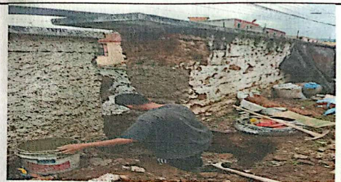
Foto 5: REALIZACIÓN DE COLUMNA
