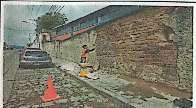
Foto 3: APLICACIÓN DE REPELLO
