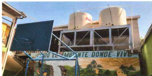
Foto 4: VISTA DE ESTRUCTURA Y TINACOS INSTALADOS AL 100%
