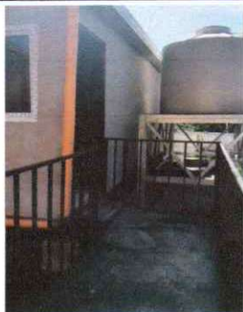
Foto 3: VISTA DE RAMPA TERMINADA AL 100%
