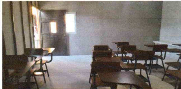
Foto 2: VISTA FACHADA INTERIOR TERMINADA AL 100%
