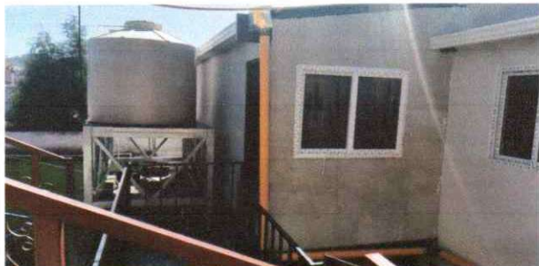
Foto1: VISTA FACHADA EXTERIOR TERMINADA AL 100%
