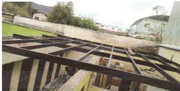
Foto 1: SUMINISTRO INICIO, FABRICACIÓN DE ESTRUCTURA PARA AULA.
