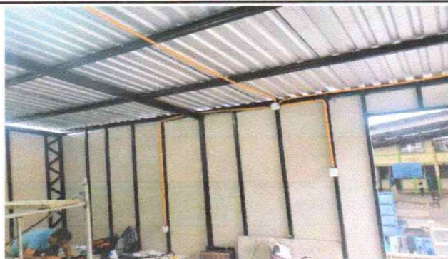
Foto 3: SUMINISTRO E INSTALACIÓN DE PLAICEM PARA EXTERIOR Y ENTECHADO DE LAMINA
