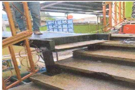
Foto 4: FABRICACIÓN DE RAMPA CON LAMINA LABRADA Y BARANDA DE METAL
