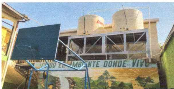
Foto 5: INSTALACIÓN DE TUBERIA Y ROTOPLAS EN ESTRUCTURA FABRICADA.
