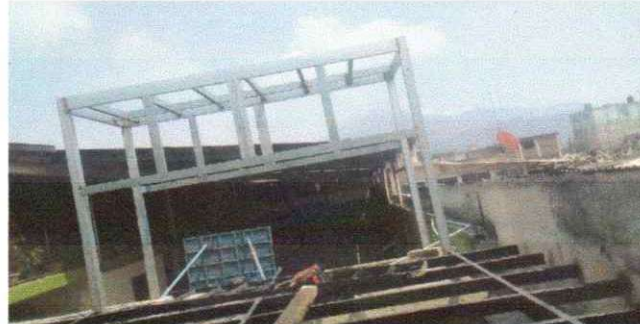
Foto 2: SUMINISTRO, FABRICACIÓN E INSTALACIÓN DE ESTRUCTURA TINACOS.
