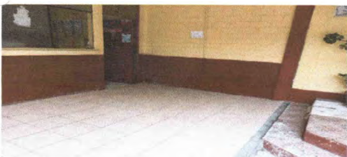
Foto 5: VISTA COLOCACIÓN DE PISO EN CORREDOR
