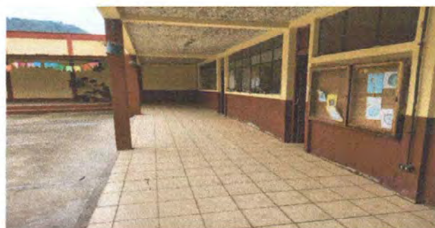
Foto 2: VISTA COLOCACIÓN DE PISO EN CORREDOR
