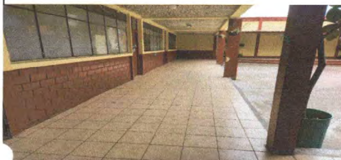
Foto 1: VISTA COLOCACIÓN DE PISO EN CORREDOR
