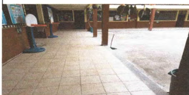
Foto 4: VISTA COLOCACIÓN PISO EN CORREDORES
