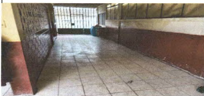
Foto 3: VISTA COLOCACIÓN DE PISO EN CORREDORES
