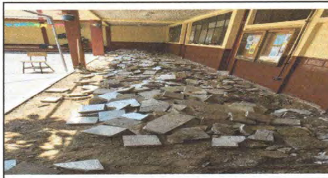
Foto 2: LEVANTADO PISO DE GRANITO EN CORREDOR
