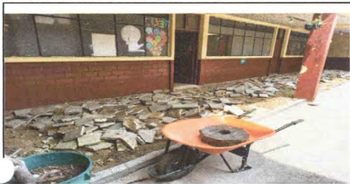
Foto 1: LEVANTADO DE PISO DE GRANITO EN CORREDOR
