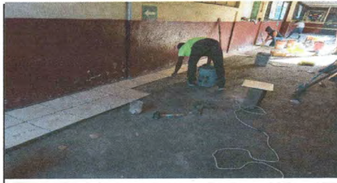
Foto 4: COLOCACIÓN DE PISO CERÁMICO EN ÁREA DE CORREDOR
