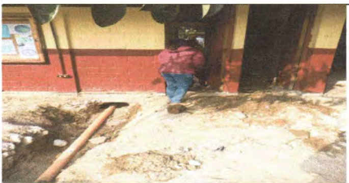
Foto 3: COLOCACIÓN DE TUBOS DE DRENAJE ÁREA DE CORREDOR.
