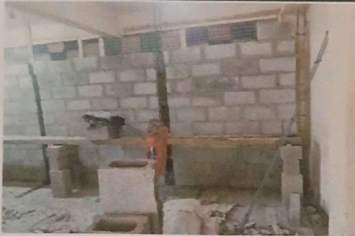
Foto1: VISTA FACHADA INTERIOR PARED CONSTRUIDA
