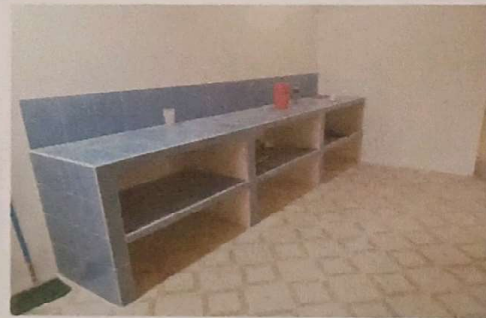
Foto 4: CONSTRUCCIÓN DE GABINETES
