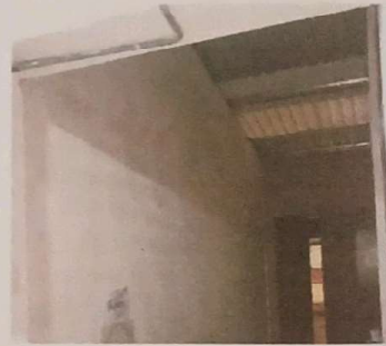
Foto 2: PARED CULMINADA Y COLOCACIÓN DE LÁMINA TROQUELADA
