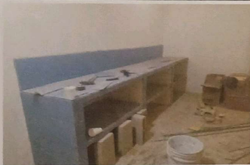
Foto 3: CONSTRUCCIÓN DE GABINETES
