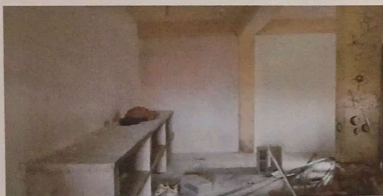
Foto 3: Construcción de gabinetes
