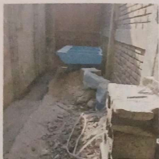
Foto1: CONSTRUCCIÓN DE PARED
