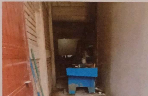
Foto 6: Instalación de pila
