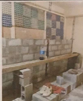
Foto 2: CONSTRUCCIÓN DE PARED
