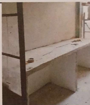
Foto 4: construcción de gabinetes
