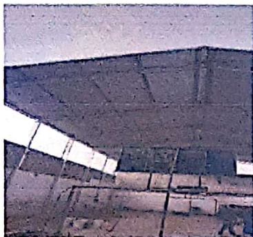
Foto1: VISTA FACHADA INTERIOR LAMINA COLOCADA AL 100%
