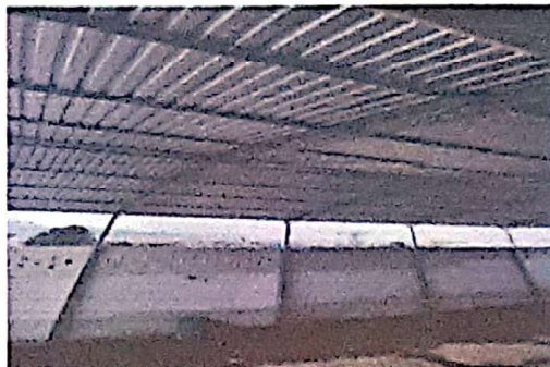
Foto 2: VISTA DE INSTALACIÓN DE LÁMINA FINALIZADO
