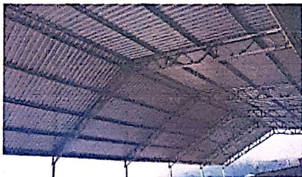
Foto 3: VISTA INTERIOR DEL TECHO
