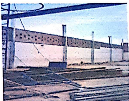
Foto 3: INSTALACIÓN DE BASES DE ESTRUCTURA METALICA PORTANTE
