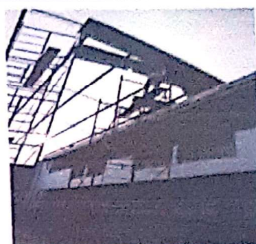
Foto 2: RETIRO DE ESTRUCTURA Y LÁMINAS ANTIGUAS DEL TECHO DEL PATIO
