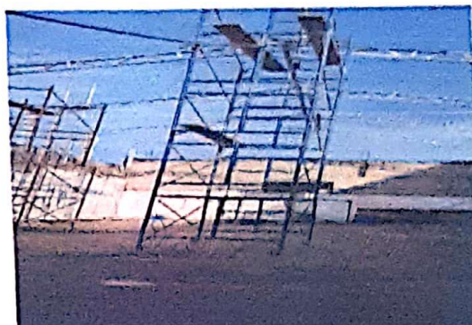
FOTO 4: SUMINISTRO POR INSTALACIÓN DE ESTRUCTURA METALICA PORTANTE PARA EL TECHO DEL PATIO DE LA ESCUELA
