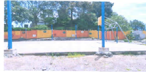
Suministro e instalacion de cubierta de lamina para cancha
