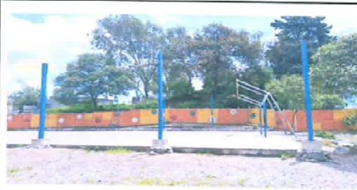
suministro e instalacion de estructura metalica para cancha
