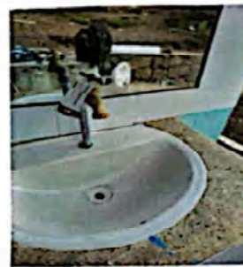
Foto 4: Instalacion y habilitacion de lavamanos
