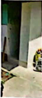
Foto 1: levantamiento de muro para baño
