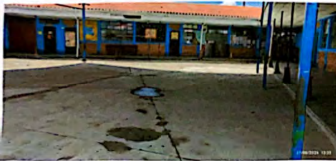
Foto 3: Fundición y reposición de torta de concreto
