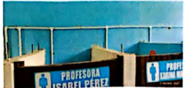
Foto 2: Mejoramiento y habilitación de lavamanos y baños.
