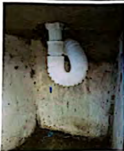
Foto 3: Reparacion y habilitacion de manguera de abasto para lavamanos.
