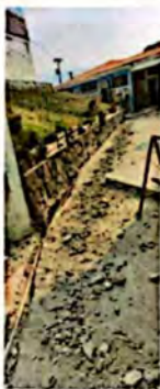
Foto 5: Suministro e intalacion de tuberia primer patio
