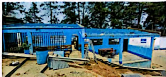
Foto 2: Suministro, cambio e instalacion de lamina
