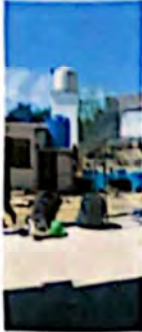
Foto 1: Suministro, habilitacion e instalacion de deposito de agua de 2,500 lts
