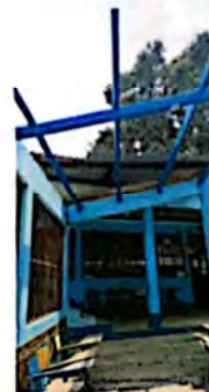
Foto 4: Mantenimiento a estructura de techo de metal con pintura anticorrosiva
