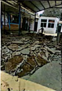
Foto 3: Suministro, demolicion de base de torta de concreto
