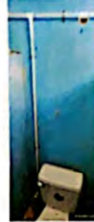
Foto 2: Suministro e instalacion de accesorios para mejoramiento y habilitacion de lavamanos pilas e inodoros
