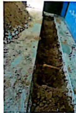
Foto 4: Instalacion tuberia de 1/2 para agua potable
