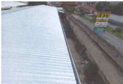
Foto 3: VISTA EXTERIOR LAMINA Y CANAL
