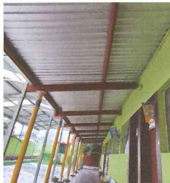
Foto 4: VISTA DE SUMINISTRO E INSTALACIÓN DE LAMINAS AREA PASILLO
