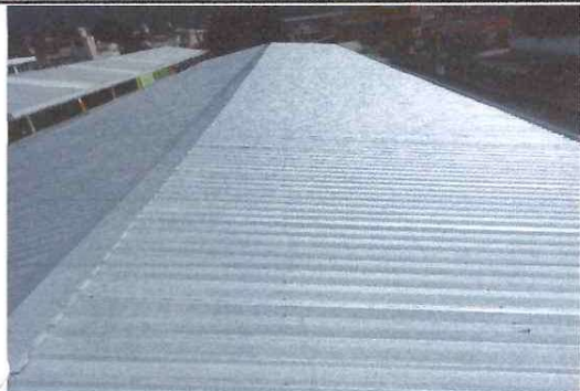
Foto1: VISTA LAMINA COLOCADA AL 100%
