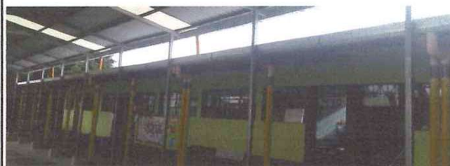
Foto 6: VISTA EXTERIOR DE CANAL FINALIZADO
