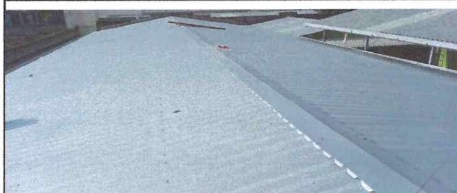
Foto 2: VISTA DE INSTALACIÓN DE LÁMINA Y CAPOTE FINALIZADO
