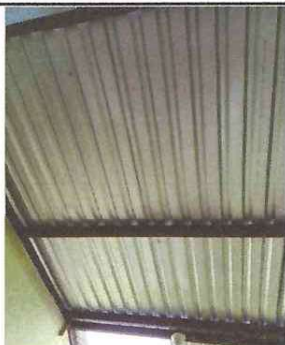
Foto 5: INTERIOR DELAS AULAS CON SUMINISTRO E INSTALACIÓN DE LAMINAS FINALIZADO
