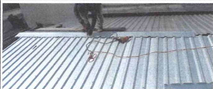
Foto 3: SUMINISTRO E INSTALACIÓN DE CAPOTES EN TECHO
