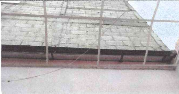
Foto1: RETIRO DE LÁMINAS ANTIGUAS
