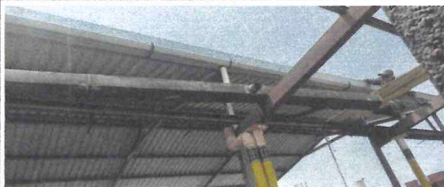
Foto 4: CAMBIO DE CANALES
