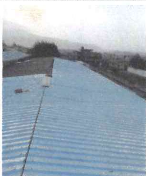
Foto 5: SUMINISTRO E INSTALACIÓN DE LÁMINAS
