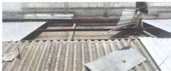
Foto 2: SUMINISTRO E INSTALACIÓN DE LÁMINA PRIMERA FASE
