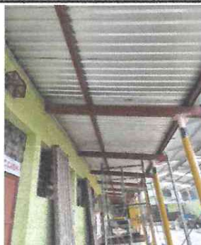
Foto 6: FINALIZA LA COLOCACIÓN DE LÁMINAS
