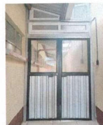
Foto 2: PUERTA DE COCINA COLOCADA
