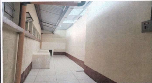
Foto 1: VISTA TERMINADA DE TECHO, ENERGIA ELECTRICA, REPELLO DE PARED, INSTALACIÓN DE CANAL, AGUA Y DREJANES DE LA COCINA
