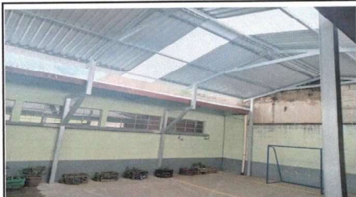
Foto 2: VISTA DE LAMINAS TRANSPARENTES COLOCADAS
