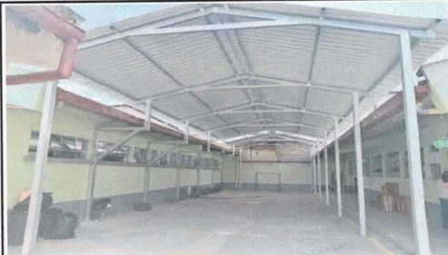
Foto1: LAMINA COLOCADA AL 100% VISTA FRONTAL
