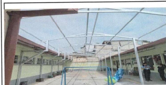
Foto 3: Colocación de Vigas y costaneras de soporte para láminas
