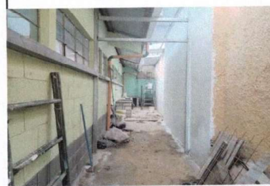
Foto 2: Colocación de Techo, fundición de mesas de trabajo y repello de pared.
