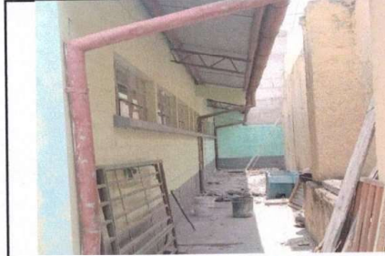
Foto 1: Inicio de limpieza de remozamiento de Cocina
