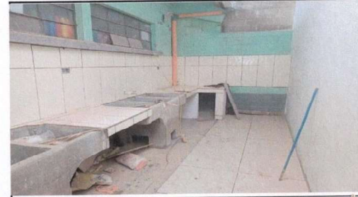
Foto 3: Colocación de pisos y azulejos.
