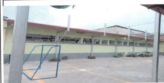
Foto 2: Colocación de Estructura para techos.
