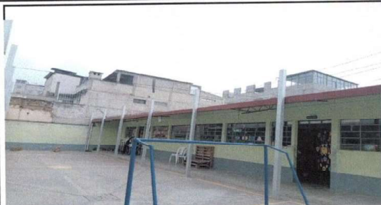
Foto 1: Fundición y Colocación de Columnas para la estructura
