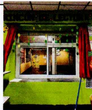
Foto 6: VISTA INTERIOR DE INSTALACIÓN DE VENTANA DE PVC.
