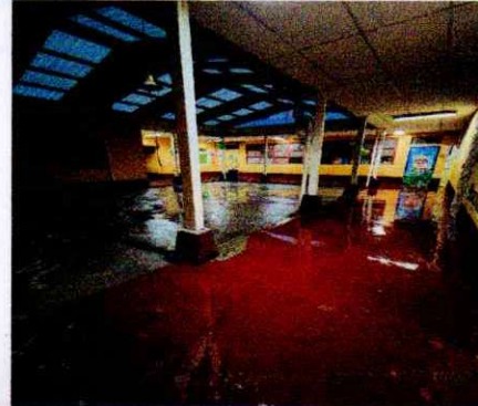
Foto 2: VISTA FINAL DE TRABAJO EN EL SUELO DE CONCRETO DE LA CANCHA.
