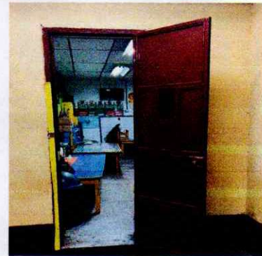
Foto 4: INSTALACIÓN DE PUERTA
