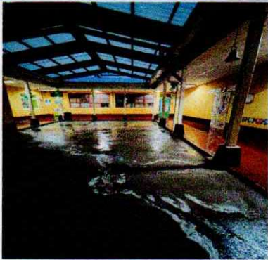
Foto 3: VISTA FINAL DE TRABAJO EN EL SUELO DE CONCRETO DE LA CANCHA.
