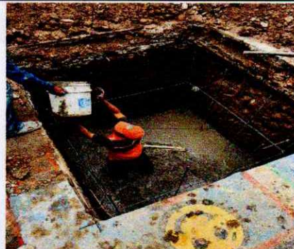
Foto 2: COLADO DE CONCRETO PARA EL SUELO DE LA CISTERNA
