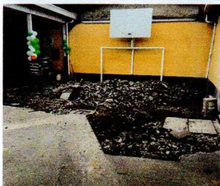
Foto 3: DEMOLICIÓN DEL PAVIMENTO DE CONCRETO DE LA CANCHA
