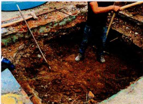
Foto1: EXCAVACIÓN DE ZANJA PARA CISTERNA
