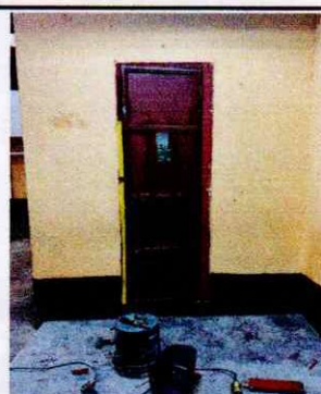
Foto 6: INSTALACIÓN DE PUERTAS Y VENTANAS DE PVC.
