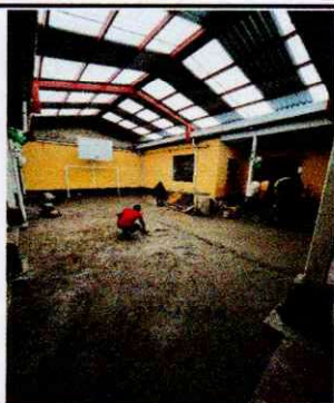
Foto 5: SEGUNDO, COLADO DE CONCRETO EN CANCHA.
