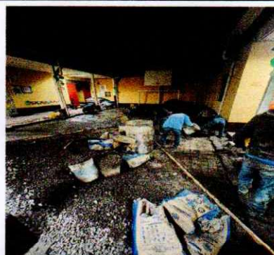
Foto 4: PRIMER, COLADO DE CONCRETO EN CANCHA.
