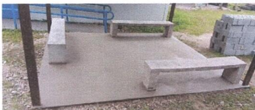
Foto 3: Sustitución de piso de torta de concreto
