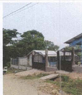
Foto: Sustitución a portones de metal
