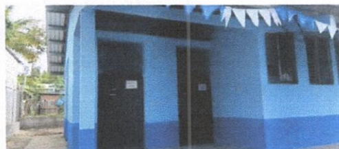
Foto 2: Pintura de muros exteriores e interiores
