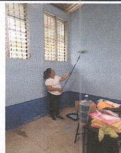
Foto 2: Pintura de muros exteriores e interiores
