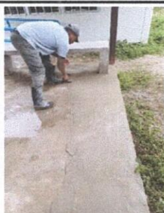
Foto 3: Sustitución de piso de torta de concreto
