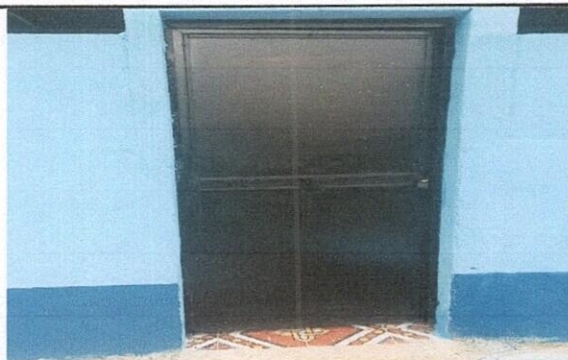
Foto 5: 4.3 sustitución de puertas
