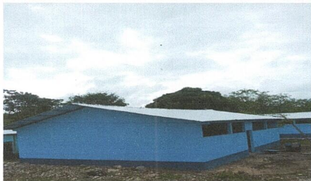
Foto7: 1.2 Sustitucion de capote de lamina para lamina troquelada
