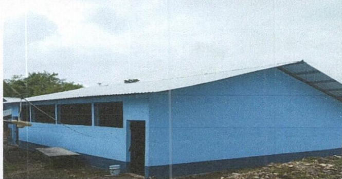
Foto 8: 9.1 Pintura en Muros exteriores e interiores..
