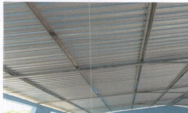
Foto 2: 2.2Sustitucion de estructura de soporte de madera, por metal.
