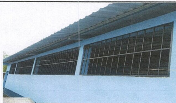
Foto 4: 19.1 Fabricacion e instalacion de ventana-balcon de metal
