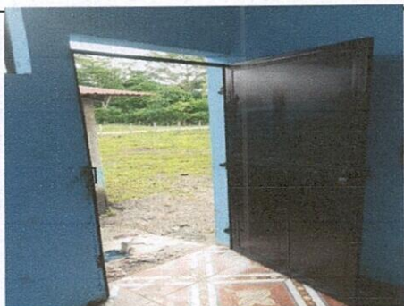
Foto 5: 4.3 sustitución de puertas
