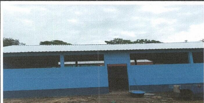
Foto7: 1.2 Sustitucion de capote de lamina para lamina troquelada
