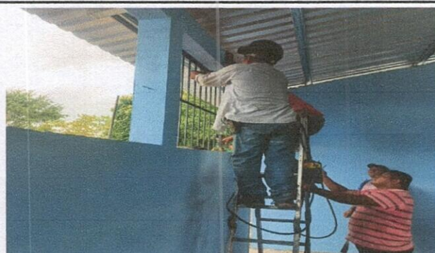
Foto 4: 19.1 Fabricacion e instalacion de ventana-balcon de metal
