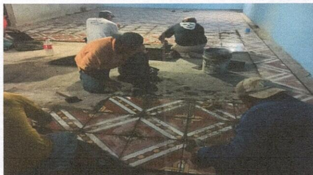
Foto 3: 6.8 Sustitucion de piso ceramico.
