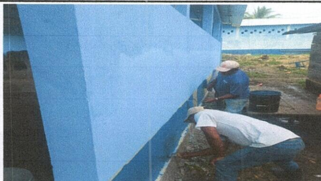
Foto 8: 9.1 Pintura en Muros exteriores e interiores..
