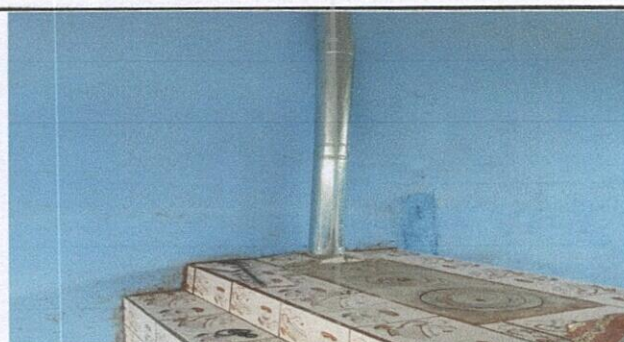
Foto 6: 20.2 Sustitucion de estufa rural (completa) incluye chimenea y plancha de metal
