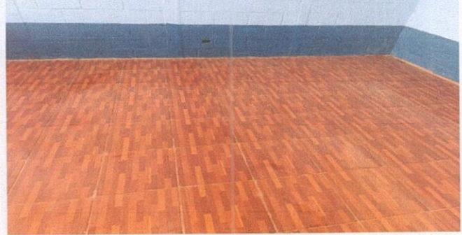
Foto 6: 6.8 Sustitucion de piso ceramico.
