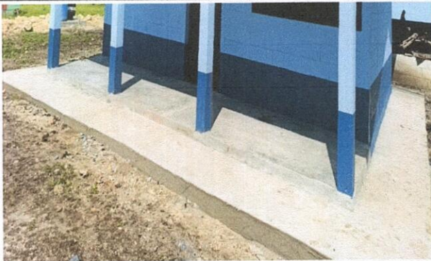
Foto 3: 8.2 Sustitucion de piso de concreto
