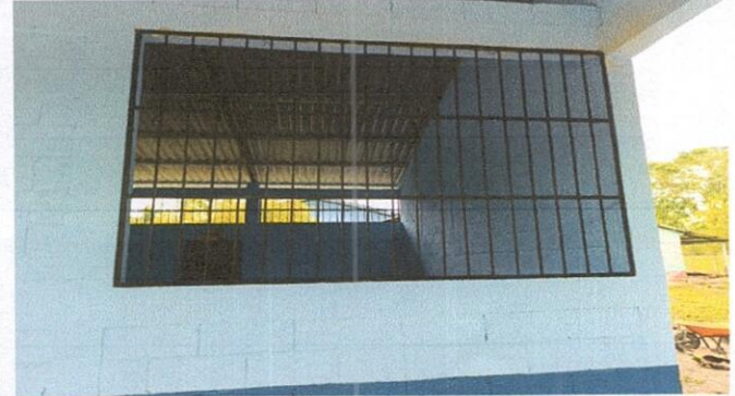
Foto 2: 19.1p Fabricacion e instalacion de ventana-balcon de metal
