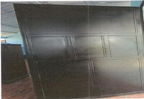
Foto 5: 4.3 sustitución de puertas
