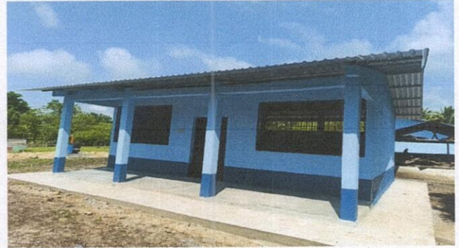
Foto 4: 9.1 Pintura en Muros exteriores e interiores.
