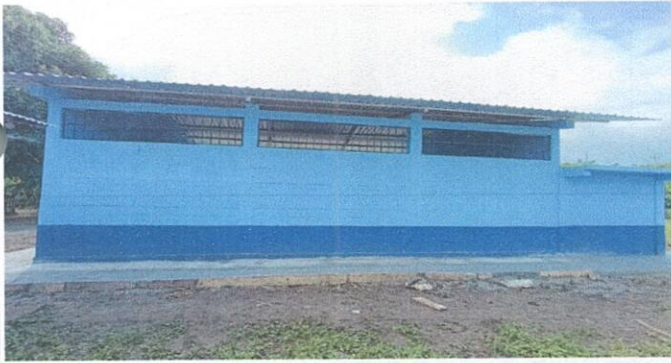
Foto1: 2.3 Sustitucion de estructura de soporte de metal, por metal.
