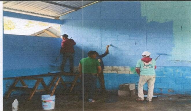
Foto 4: 9.1 Pintura en Muros exteriores e interiores.
