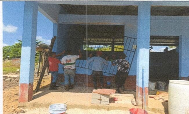
Foto 2: 19.1 Fabricacion e instalacion de ventana-balcon de metal
