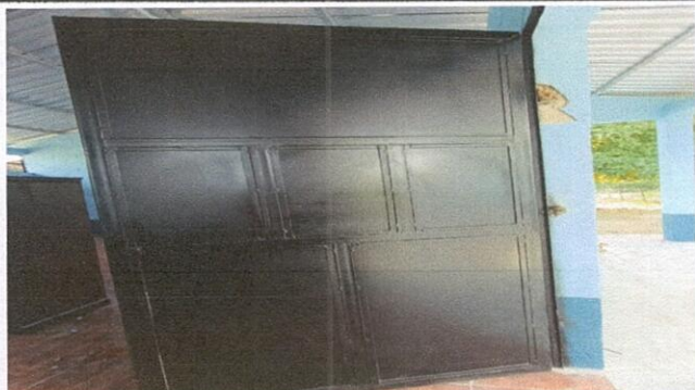
Foto 5: 4.3 sustitución de puertas
