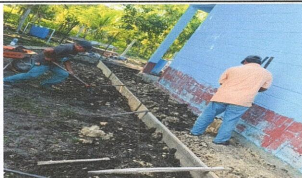
Foto 3: 8.2 Sustitucion de piso de concreto
