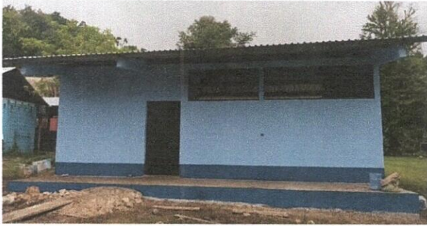
Foto1: CUBIERTA DE LÁMINA
