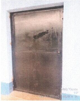
Foto 3: FABRICACIÓN E INSTALACIÓN DE PUERTA DE METAL EN MODULO
