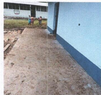
Foto 6: REPARACIÓN DE BANQUETAS DE CONCRETO
