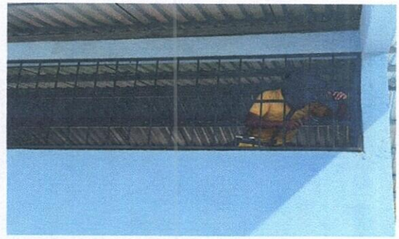
Foto 4: FABRICACIÓN E INSTALACIÓN VENTANA-BALCÓN DE METAL
