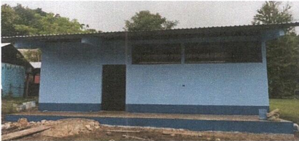
Foto 7: PINTURA EN MUROS DE INTERIORES Y EXTERIORES
