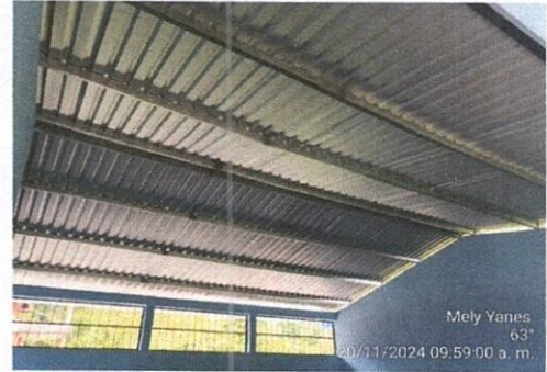
Foto 2: ESTRUCTURA DE TECHO
