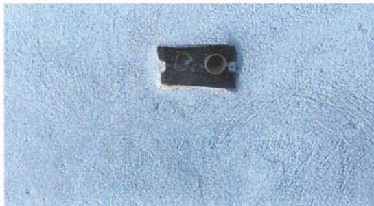
Foto 9: SUSTITUCIÓN DE DUCTO ELECTRICO+ACCESORIOS
