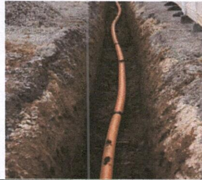
Foto 8: SUSTITUCIÓN DE TUBERIA PVC LINEA PRINCIPAL AGUAS NEGRAS
