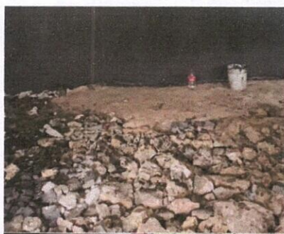
Foto 5: SUSTITUCIÓN DE PISO DE TORTA DE CONCRETO
