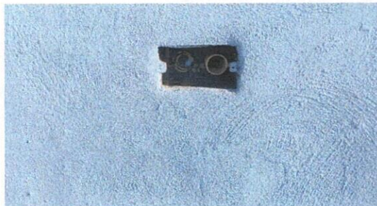
Foto 9: SUSTITUCIÓN DE DUCTO ELÉCTRICO+ACCESORIOS
