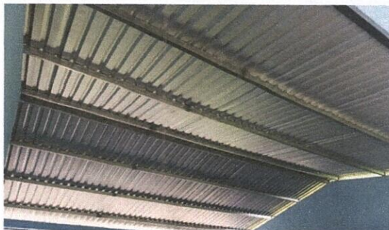
Foto1: CUBIERTA DE LÁMINA
