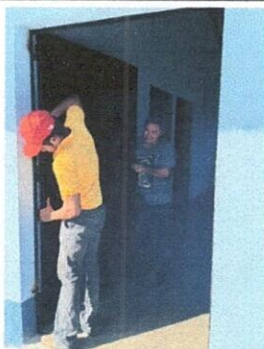
Foto 3: FABRICACIÓN E INSTALACIÓN DE PUERTA DE METAL EN MODULO
