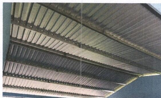
Foto 2: ESTRUCTURA DE TECHO
