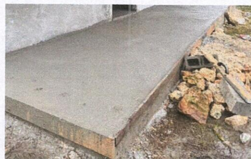
Foto 6: REPARACIÓN DE BANQUETAS DE CONCRETO
