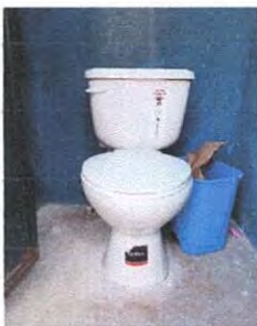
Foto 5: Sustitución de indoros
