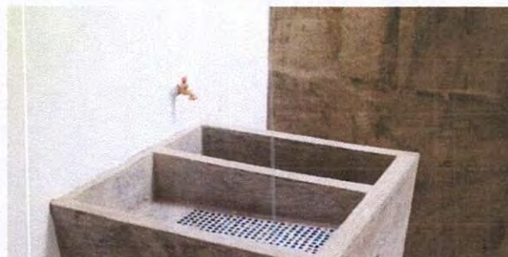
Foto 10: Sustitución de llaves de chorros
