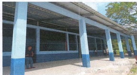
Foto 6: Sellado en grietas y fisuras en muros
