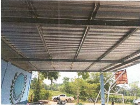
INSTALACIÓN DE ESTRUCTURA PORTANTE DE METAL
