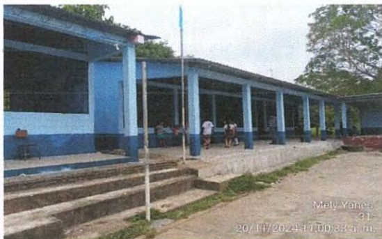
Foto 9: Pinturas en muros exteriores e interiores
