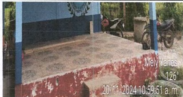
SUSTITUCIÓN DE PISO CERÁMICO
