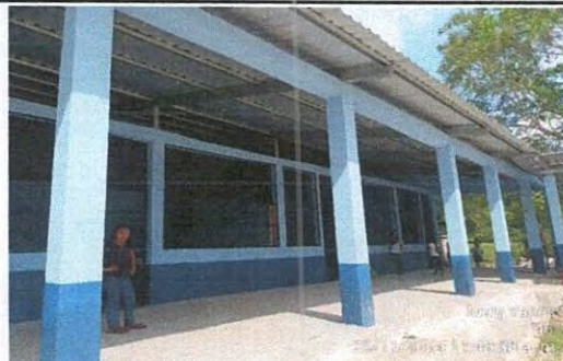
Foto 8: Reparación de piso de torta de concreto
