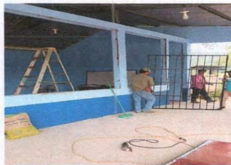
Foto 4: Fabricación e instalación de balcones de hierro en ventanas
