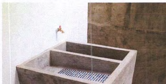
Foto 10: Sustitución de llaves de chorros
