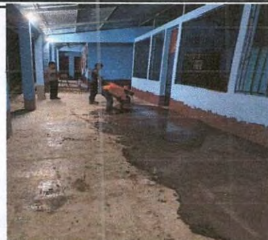
Foto 8: Reparación de piso de torta de concreto
