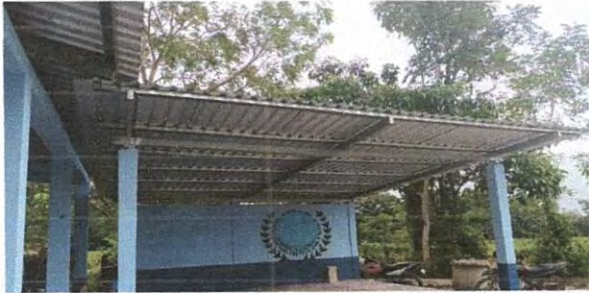
INSTALACIÓN DE ESTRUCTURA PORTANTE DE METAL
