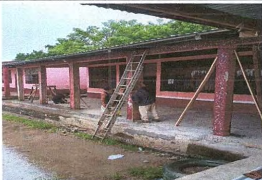
Foto 7: Repello en muros
