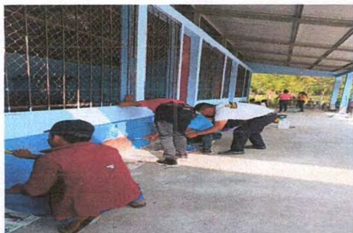
Foto 9: Pinturas en muros exteriores e interiores
