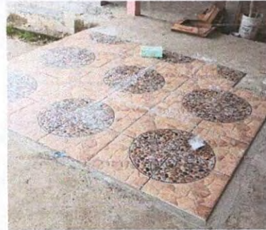
SUSTITUCIÓN DE PISO CERÁMICO
