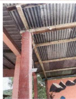
Foto 12: Sustitución de ducto eléctrico+accesorios
