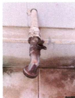
Foto 10: Sustitución de llaves de chorros
