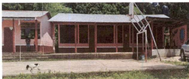
Foto 9: Pinturas en muros exteriores e interiores
