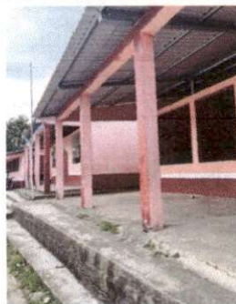
Foto 8: Pintura en muros exteriores e interiores
