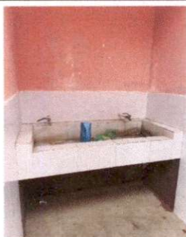
Foto 11: Instalación de chorros
