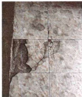
Foto 7: sustitucion de piso ceramica
