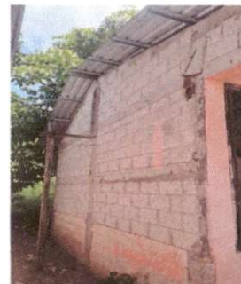
Foto 6: Sellado en grietas y fisuras en muros
