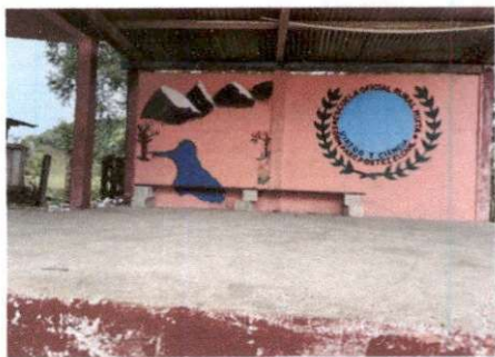
Foto 7: Reparación de piso de torta de concreto ✓
