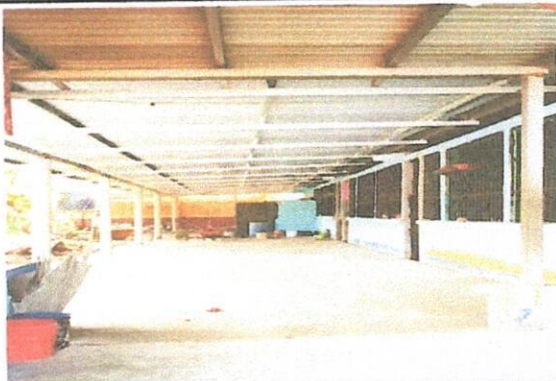
Foto 1: sustitucion de estructura de soporte de madera, por metal
