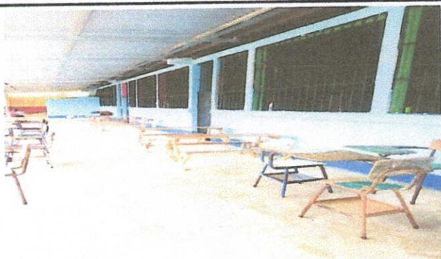
Foto 3: sustitucion de piso de torta de concreto
