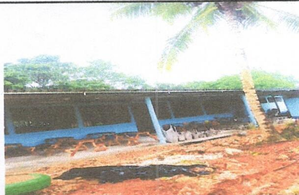
Foto 2: sustitucion de lamina, por lamina troquelada aluzinic calibre 26
