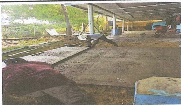
Foto 3: sustitucion de piso de torta de concreto
