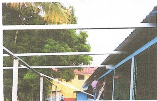
Foto 1: sustitución de estructura de soporte de madera, por metal
