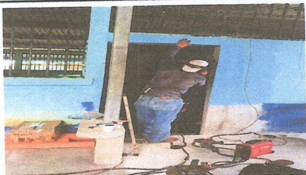
5. Sustitucion de puertas
