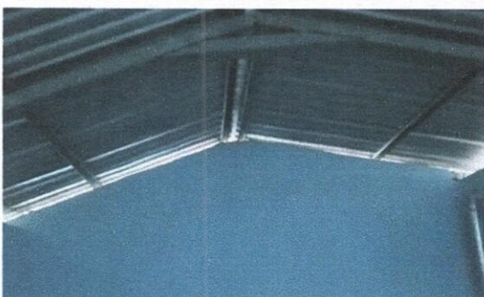
Foto 5: Sustitución de lámina troquelada aluzinc calibre 26
