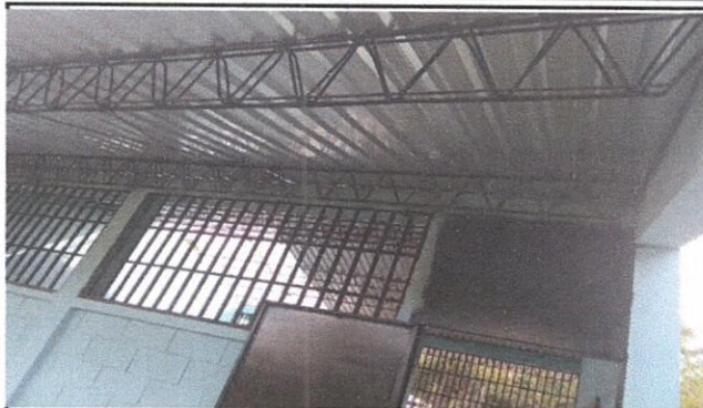
Foto 1: Mantenimiento a Estructura de Soporte de Metal
