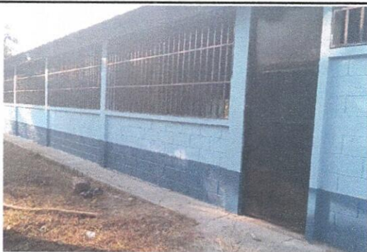
Foto 3: sustitución de balcones
