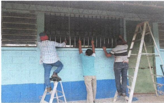
Foto 3: sustitucion de balcones
