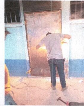
Foto 2: Sustitución de Puertas
