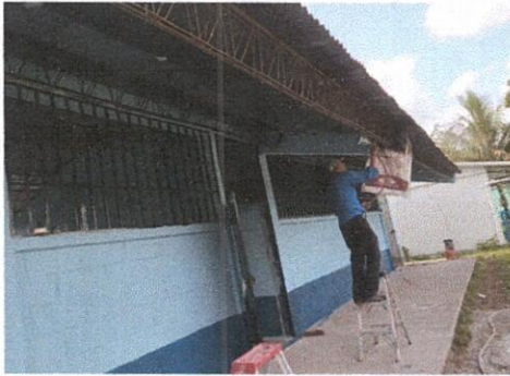
Foto1: Mantenimiento a Estructura de Soporte de Metal
