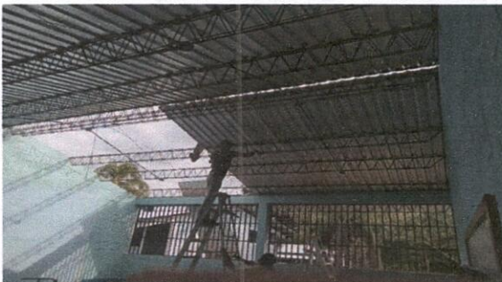
Foto 5: Sustitución de lámina troquelada aluzinc calibre 26
