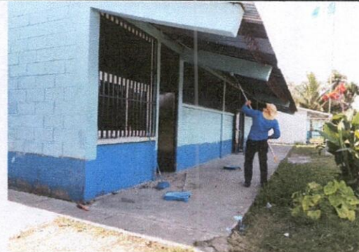
Foto 4: Pintura en Muros exteriores e interiores
