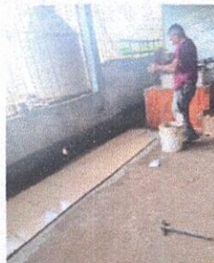
Foto 2: SUSTITUCIÓN DE PISO CERAMICO
