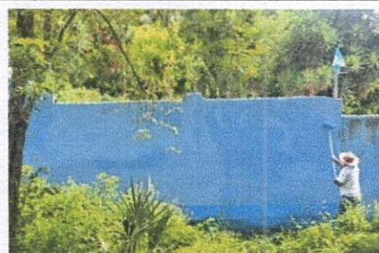
Foto 6: PINTURA EN MUROS EXTERIORES E INTERIORES
