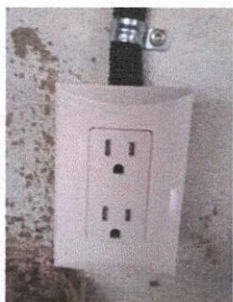
Foto 3: SUSTITUCIÓN DE TOMACORRIENTES DOBLES
