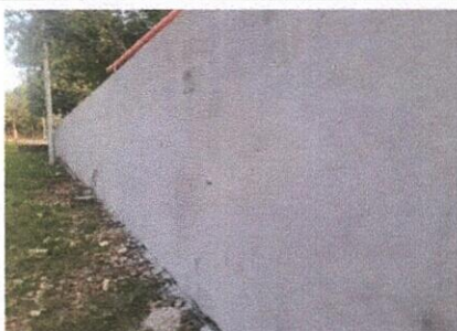
Foto 3: APLICACIÓN DE REPELLO DE MURO DE CONTENCIÓN
