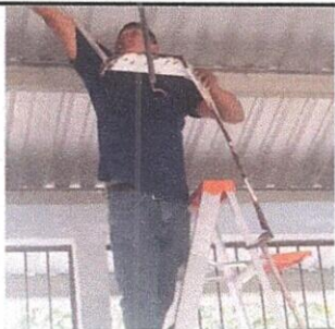
Foto1: SUSTITUCIÓN DE FOCOS AHORRADORES
