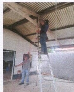
Foto 4: REPARACIÓN DE CABLEADO ELECTRICO
