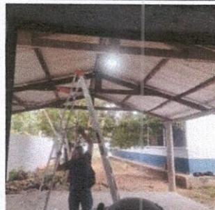
Foto 2: INSTALACIÓN DE UNIDAD DE LUZ
