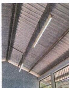
Foto 5: SUSTITUCIÓN DE LAMPARAS TIPO LED
