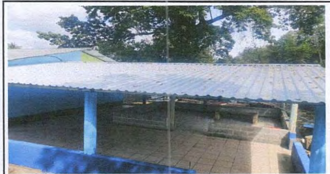
Foto 12: INSTALACIÓN DE LÁMINA TROQUELADA ALUZINC
