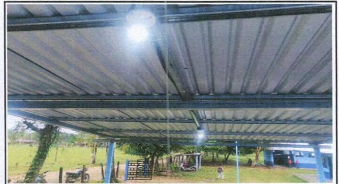
Foto 4: SUSTITUCIÓN DE LAMPARAS AHORRADORAS
