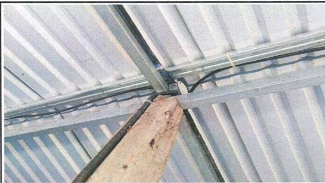
Foto 3: REPARACIÓN DE CABLEADO ELÉCTRICO
