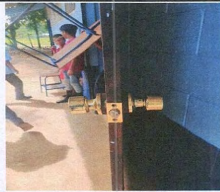
Foto 16: SUSTITUCIÓN DE CHAPA
