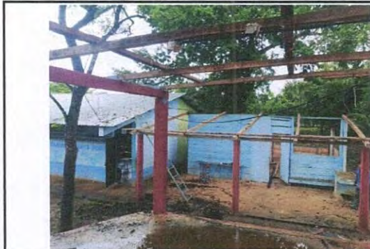
Foto 11: DESINSTALACIÓN DE LÁMINA EXISTENTE
