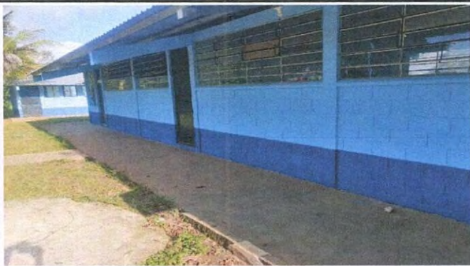
Foto 15: PINTURA DE MUROS DE INTERIORES Y EXTERIORES
