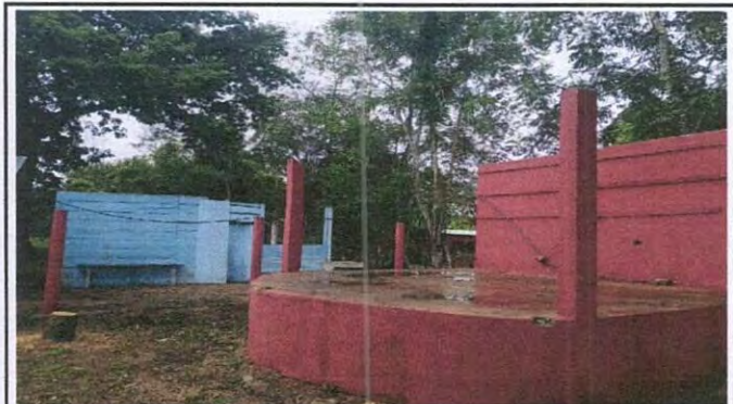
Foto 10: DESINSTALACIÓN DE ESTRUCTURA PORTANTE
