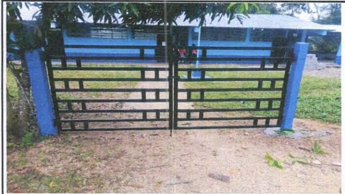
Foto 8: SUSTITUCIÓN DE PORTÓN DE METAL
