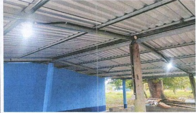
Foto 14: INSTALACIÓN DE UNIDADES DE LUZ (INCLUYE CABLE ELECTRICO)
