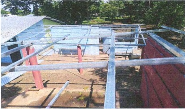
Foto 13: INSTALACIÓN DE ESTRUCTURA PORTANTE DE METAL
