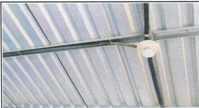
Foto 5: SUSTITUCIÓN DE PLAFONERAS
