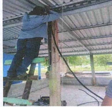
Foto 14: INSTALACIÓN DE UNIDADES DE LUZ (INCLUYE CABLE ELECTRICO)
