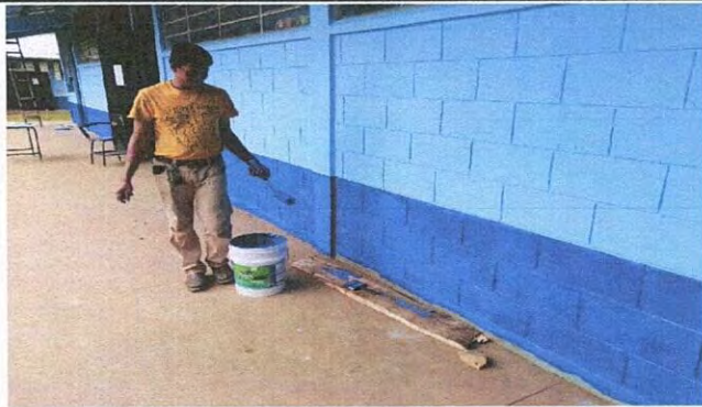
Foto 15: PINTURA DE MUROS DE INTERIORES Y EXTERIORES
