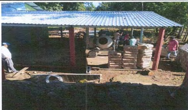
Foto 9: SUSTITUCIÓN DE PISO DE TORTA DE CONCRETO
