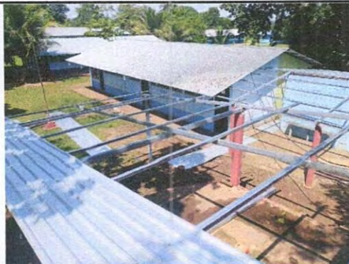
Foto2: SUSTITUCIÓN DE LÁMINA, POR LÁMINA TROQUELADA ALUZING CALIBRE 26
