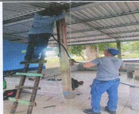
Foto 4: SUSTITUCIÓN DE LAMPARAS AHORRADORAS
