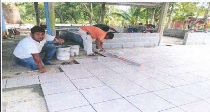
Foto7: REPARACIÓN DE PISO CERÁMICO
