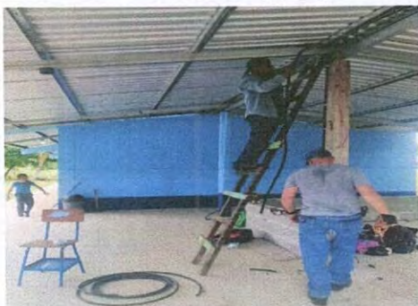
Foto 5: SUSTITUCIÓN DE PLAFONERAS
