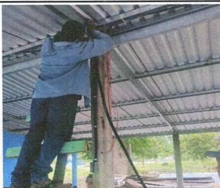
Foto 3: REPARACIÓN DE CABLEADO ELÉCTRICO
