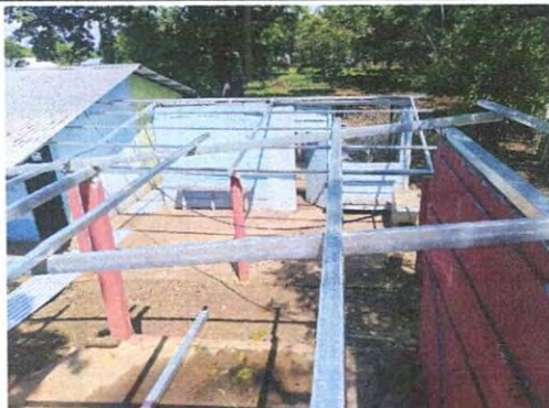
Foto1: SUSTITUCIÓN DE ESTRUCTURA DE SOPORTE DE MADERA POR METAL
