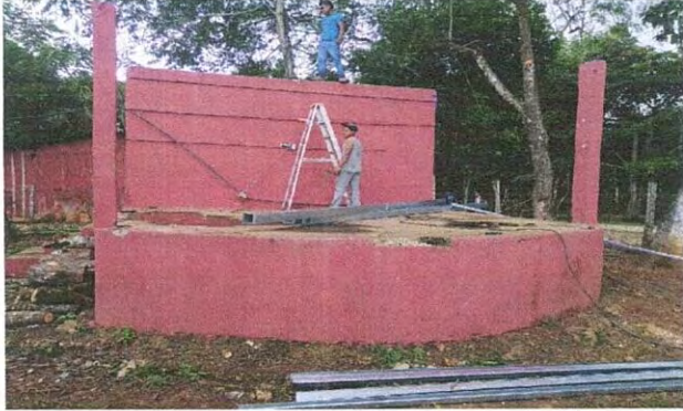
Foto 13: INSTALACIÓN DE ESTRUCTURA PORTANTE DE METAL
