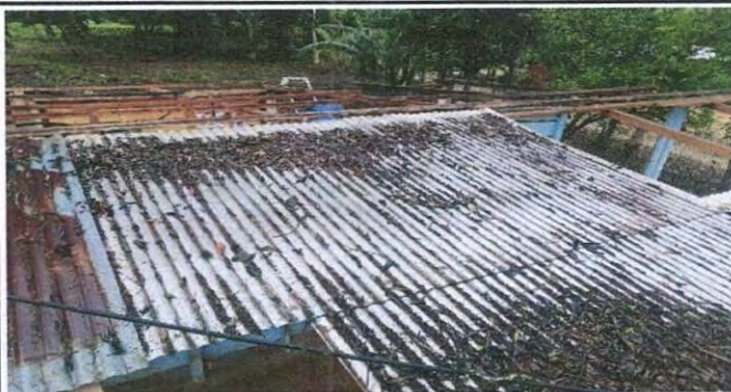
Foto 11: DESINSTALACIÓN DE LÁMINA EXISTENTE
