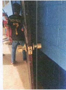
Foto 16: SUSTITUCIÓN DE CHAPA
