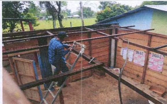
Foto 10: DESINSTALACIÓN DE ESTRUCTURA PORTANTE
