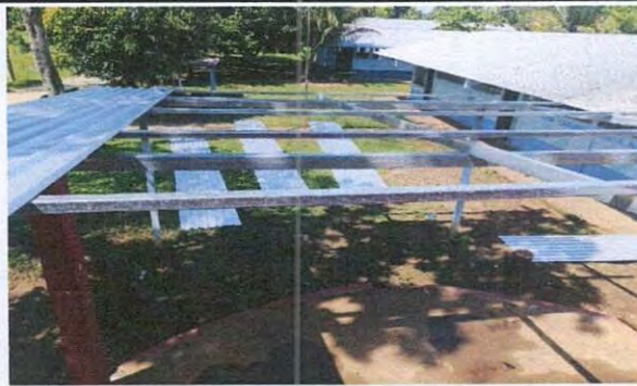
Foto 12: INSTALACIÓN DE LÁMINA TROQUELADA ALUZINC
