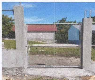
Foto 4: Fabricación instalación de porton de metal de ingreso 1.5mx2m
