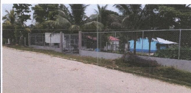
Foto 2: Repación de Muro Perimental de Block con tubo hg y malla galvanizada soleras intermedias.
