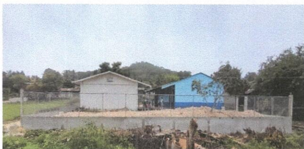
Foto1: Repación de Muro Perimental de Block con tubo hg y malla galvanizada soleras intermedias.
