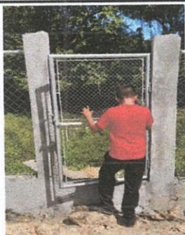
Foto 5: Fabricación instalación de porton de metal de ingreso 1mx2m
