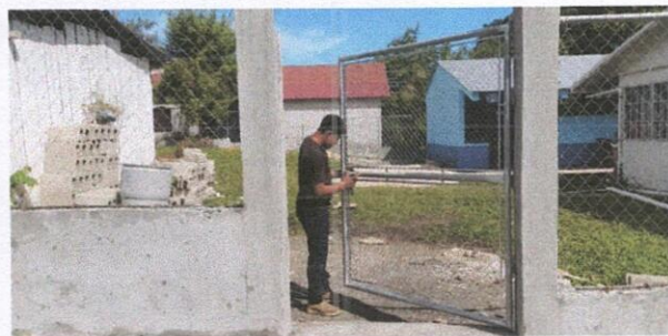
Foto 4: Fabricación instalación de porton de metal de ingreso 1.5mx2m
