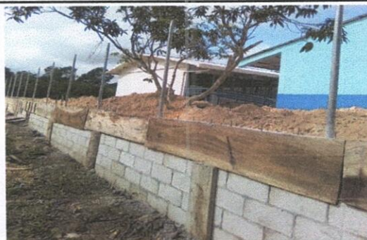
Foto 2: Repación de Muro Perimental de Block con tubo hg y malla galvanizada soleras intermedias.
