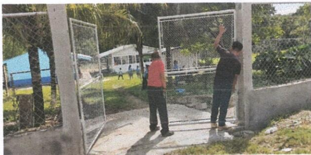
Foto 3: Fabricación instalación de porton de metal de ingreso 2.8mx2m
