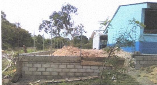
Foto1: Repación de Muro Perimental de Block con tubo hg y malla galvanizada soleras intermedias.
