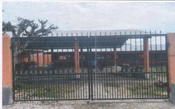
Foto 4: Sustitución de Porton de Metal
