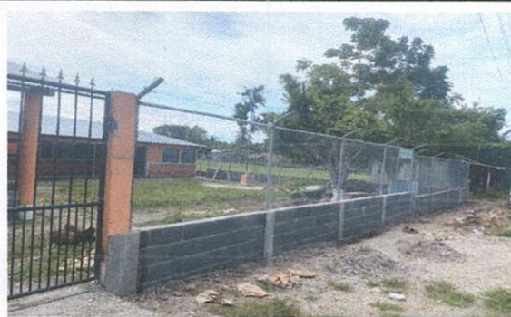
Foto 2: sustitución de muro perimetral de block y malla galvanizada con tubo
