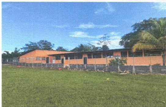
Foto 1: sustitución de muro perimetral de block y malla galvanizada
