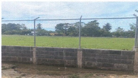
Foto 3: sustitución de muro perimetral de block y malla galvanizada con tubo
