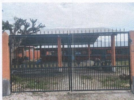
Foto 4: Sustitución de Porton de Metal
