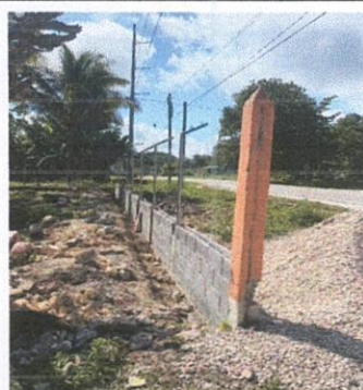
Foto 2: sustitución de muro perimetral de block y malla galvanizada con tubo
