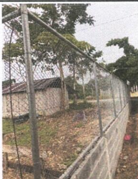
Foto 3: sustitución de muro perimetral de block y malla galvanizada con tubo
