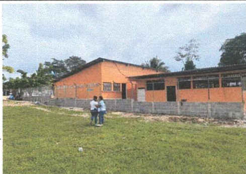
Foto 1: sustitución de muro perimetral de block y malla galvanizada
