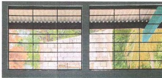
Foto 5: Sustrucción de balcones de metal
