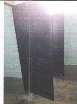
Foto 4: Sustrucción de puerta en servicios sanitarios
