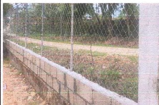
Foto 10: Reparación de muro perimetral de block
