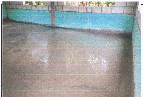
Foto 15: Sustitución de piso de torta de concreto
