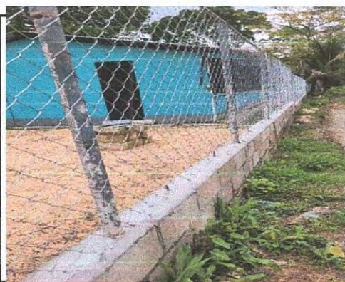
Foto 11: Reparación de tubo hg y malla galvanizada
