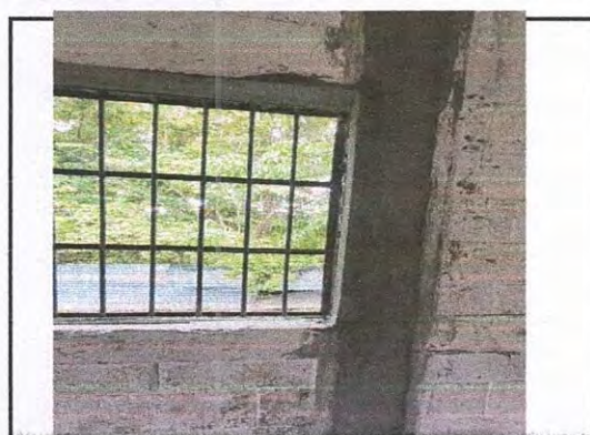
Foto 16: Repello en muro
