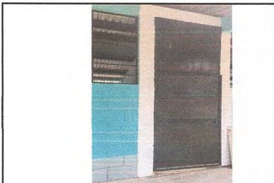
Foto 13: Mantenimiento a estructura a puertas (lijado, cambio de tubo, cepillado, sujeciones, aplicación de pintura)
