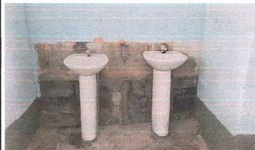
Foto 8: Sustitución de lavamanos
