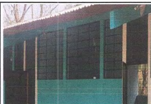
Foto 12: Mantenimiento a balcones de metal de ventana
