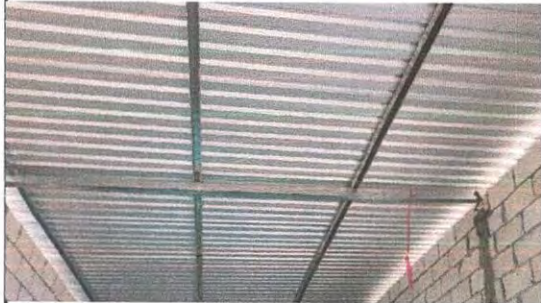
Foto 1: Sustrucción de lámina, por lámina troquelada
