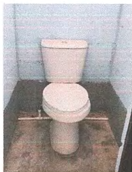
Foto 7: Sustitucion de inodoros
