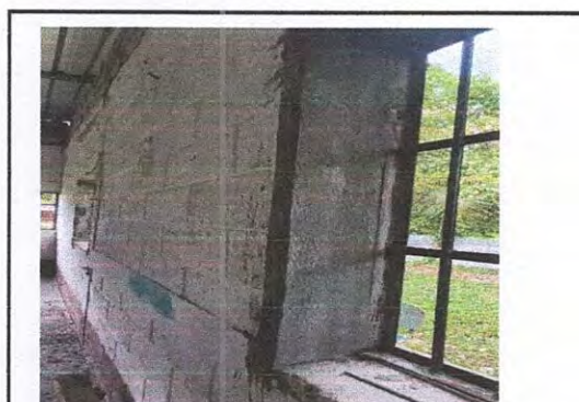
Foto 16: Repello en muro
