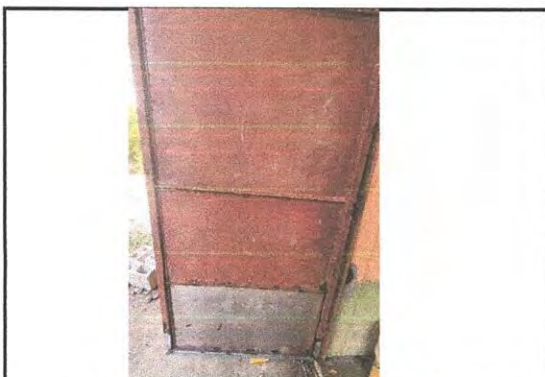
Foto 13: Mantenimiento a estructura a puertas (lijado, cambio de tubo , cepillado, sujeciones, aplicación de pintura)
