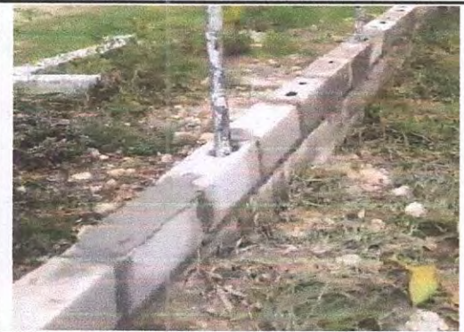
Foto 10: Reparación de muro perimetral de block
