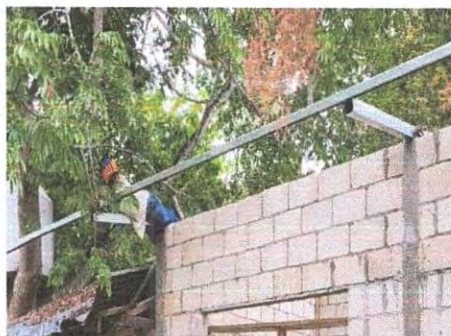
Foto 1: Sustitución de lámina, por lámina troquelada
