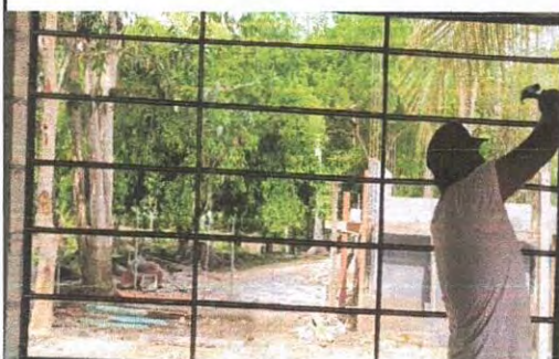
Foto 5: Sustitución de balcones de metal
