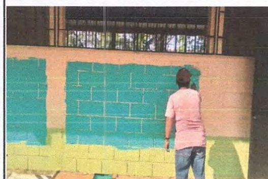
Foto 6: Pintura en muros exteriores e interiores
