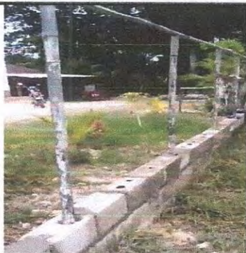
Foto 11: Reparación de tubo hg y malla galvanizada
