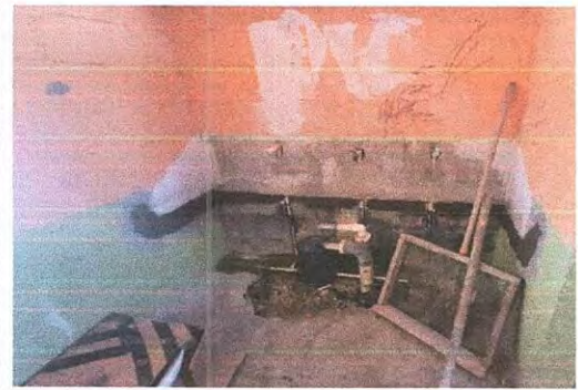
Foto 8: Sustitución de lavamanos
