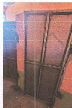
Foto 4: Sustitución de puerta en servicios sanitarios
