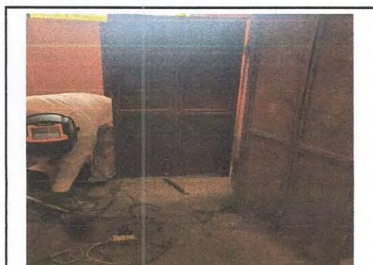
Foto14: Mantenimiento a estructura a puertas servicios sanitarios(lijado, cambio de tubo , cepillado, sujeciones, aplicación de pintura)
