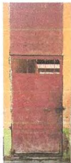
Foto 13: Mantenimiento a estructura a puertas (lijado, cambio de tubo, cepillado, sujeciones, aplicación de pintura)
