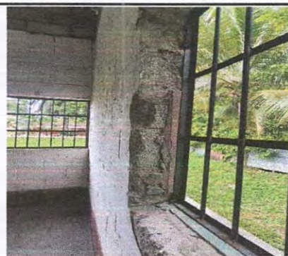
Foto 16: Repello en muro
