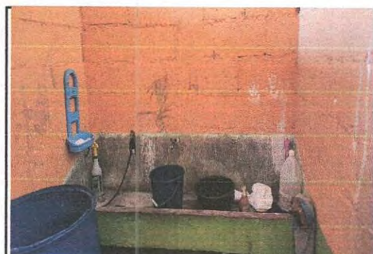
Foto 8: Sustrucción de lavamanos
