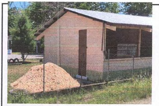
Foto 10: Reparación de muro perimetral de block
