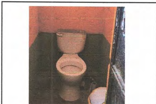
Foto 7: Sustrucción de inodoros
