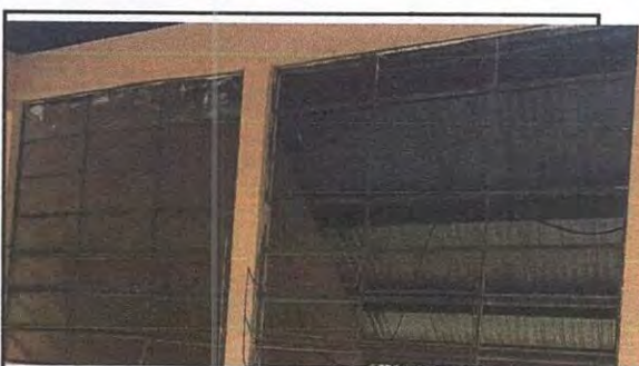
Foto 12: Mantenimiento a balcones de metal de ventana
