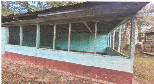
Foto 1: Sustitución de lámina, por lámina troquelada
