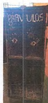
Foto 4: Sustitución de puerta en servicios sanitarios
