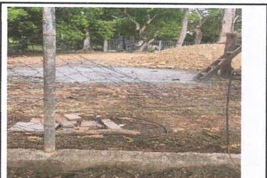
Foto 11: Reparación de tubo hg y malla galvanizada
