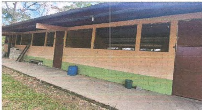
Foto 6: Pintura en muros exteriores e interiores
