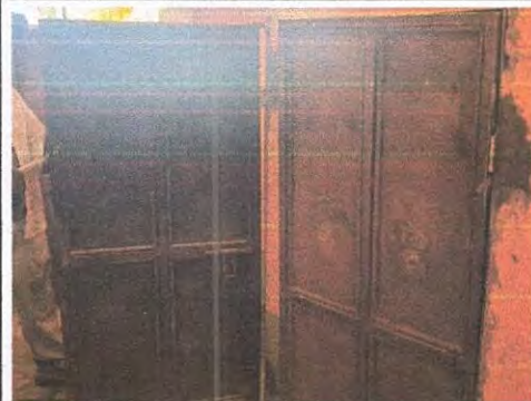
Foto 14: Mantenimiento a estructura a puertas sanitarios (lijado, cambio de tubo, cepillado, sujeciones, aplicación de pintura)
