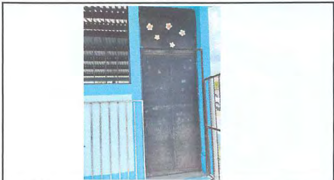
Foto 2: Mantenimiento de puerta de metal
