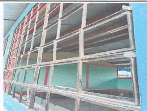
Foto 4: Sustitución de Balcones de metal
