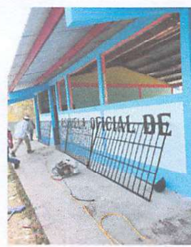
Foto 4: Sustrucción de balcones de metal
