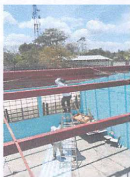
Foto 3: Mantenimiento estructura de metal
