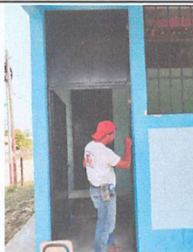
Foto 2: Mantenimiento de puerta de metal
