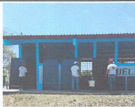
Foto 6: Sustitución de puerta de metal
