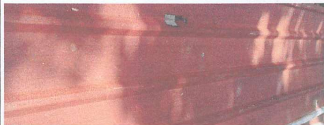
Foto 2: Sustitución de lámina, por lámina troquelada alizinc calibre 26
