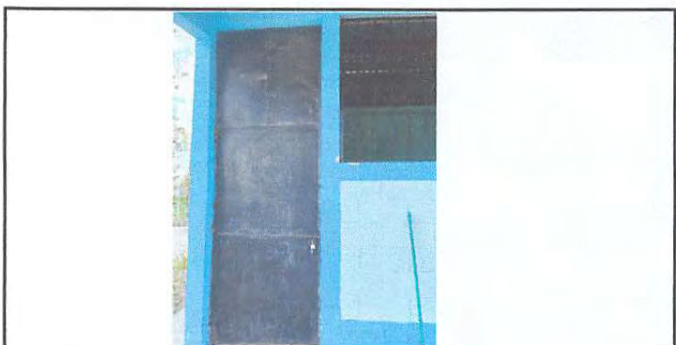
Foto 6: Sustitución de puerta de metal
