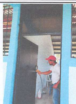
Foto 2: Mantenimiento de puerta de metal
