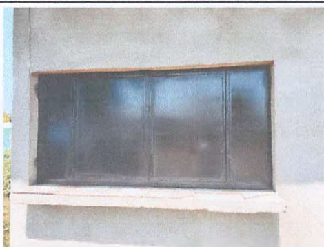
Foto 3: Sustitución de ventana de madera por ventana de metal
