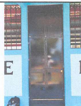
Foto 6: Sustitución de puerta de metal
