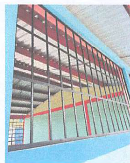
Foto 4: Mantenimiento de balcones de metal
