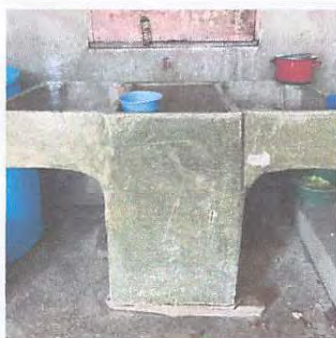
Foto 5: Sustitución de pila de semento de dos lavaderos
