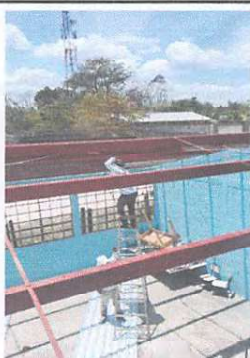
Foto 3: Mantenimiento a estructura a soporte de Metal
