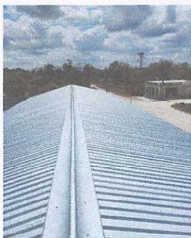
Foto1: Sustitución de capotes de lámina para lámina troquelada
