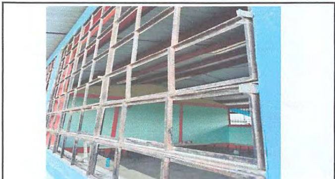
Foto 4: Mantenimiento de balcones de metal
