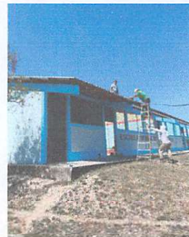
Foto 2: Sustrucción de lámina troquelada aluzinc calibre 26
