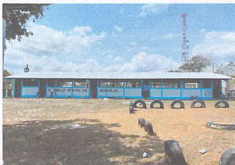
Foto 3: Sustitución de lámina troquelada aluzinc calibre 26
