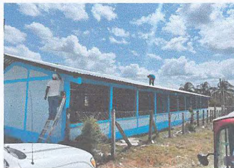
Foto 2: Sustitución de lámina troquelada aluzinc calibre 26
