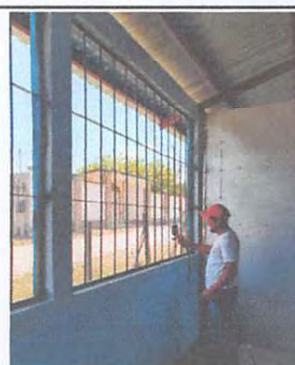
Foto 4: Mantenimiento de balcones de metal
