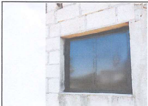
Foto 1: Sustitución de ventana de madera por ventana de metal
