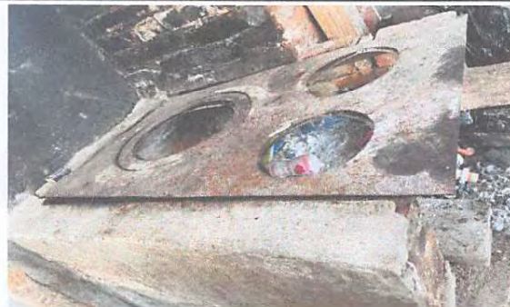
Foto 6: Sustitución de plancha de metal de tres hornillas
