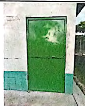
Foto 6: Sustitución de chapa, mantenimiento de estructura y pintura de puerta.
