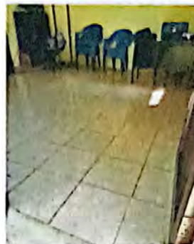
Foto 2: Sustitución de piso líquido a cerámico.
