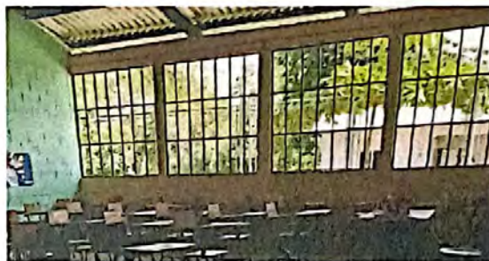
Foto 4: Mantenimiento de balcón de metal y pintura para balcón.
