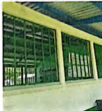
Foto 2: Mantenimiento de balcón de metal y pintura para balcón.
