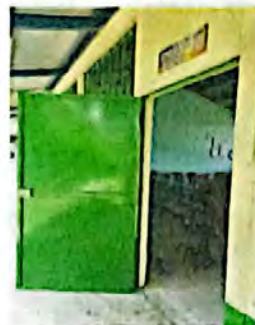
Foto 2: Sustrucción de chapa, mantenimiento de pintura y estructura.
