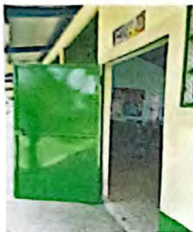
Foto 3: Sustrucción de chapa, mantenimiento de pintura y estructura.
