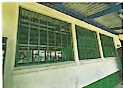
Foto 3: Mantenimiento de balcón de metal y pintura para balcón.
