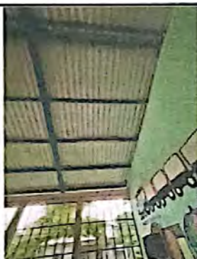
Foto 3: Sustitución de lámina, por lámina troquelada Aluzinc calibre 26
