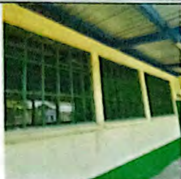
Foto 1: Mantenimiento de balcón de metal y pintura para balcón.
