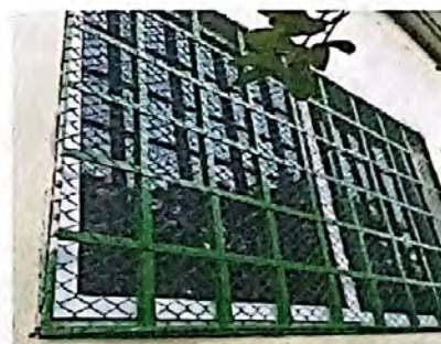
Foto 6: Sustitución de ventana de metal por vidrio
