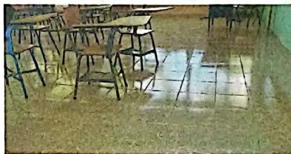
Foto 4: Sustrucción de piso líquido a cerámico.
