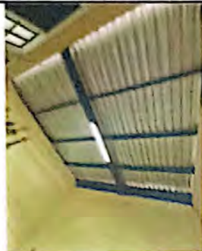
Foto1: Sustitución de lámina, por lámina troquelada Aluzinc calibre 26
