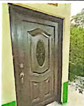
Foto 5: Fabricación e instalación de puerta de metal
