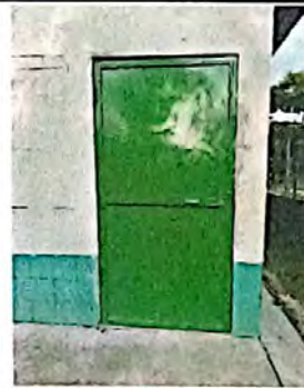
Foto 6: Sustitución de chapa, mantenimiento de estructura y pintura de puerta.
